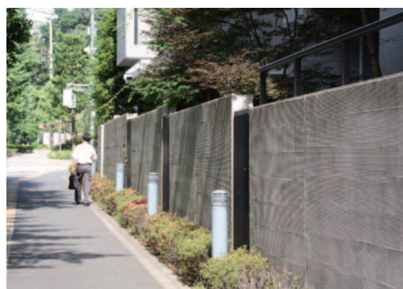
擁壁や塀を道路からセットバックさせ、植栽等により修景しましょう。
